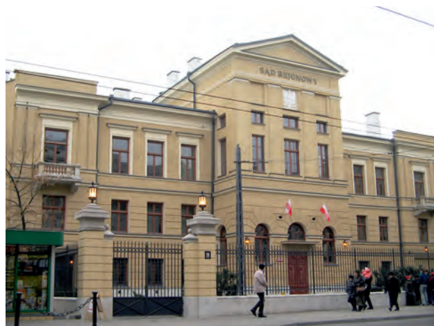
Sąd Rejonowy po remoncie w 2005 r., fot. W. Turżański
